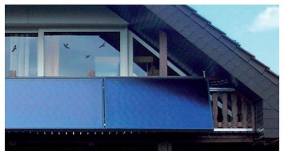
**Alle Tests bestanden!** Die K4-Kollektoren und Montagesysteme wurden am Institut für Solarenergieforschung (ISFH) in Hameln, Deutschland nach EN 12975-1/2 erfolgreich getestet und sind mit Solar Keymark Zertifikaten ausgestattet.
